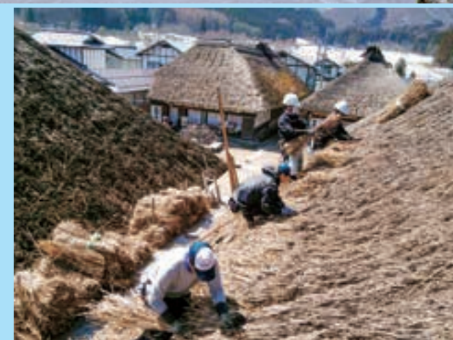
以人称“茅手”的匠人为中心，所有居民齐心协力，一起完成屋顶的茅草翻新工作
