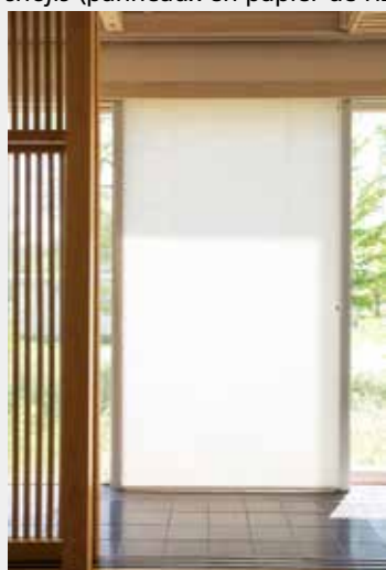
A gauche : Plusieurs panneaux alignés des deux côtés du couloir. Les panneaux d'isolation thermique et les persiennes en bois mobiles, le long des fenêtres, sont séparés de la salle de séjour par des portes vitrées. / A droite : Les panneaux d'isolation thermique sont constitués de deux couches d'une structure en nid d'abeille afin d'éviter les pertes de chaleur. (Photo : Kusu Seiko)
