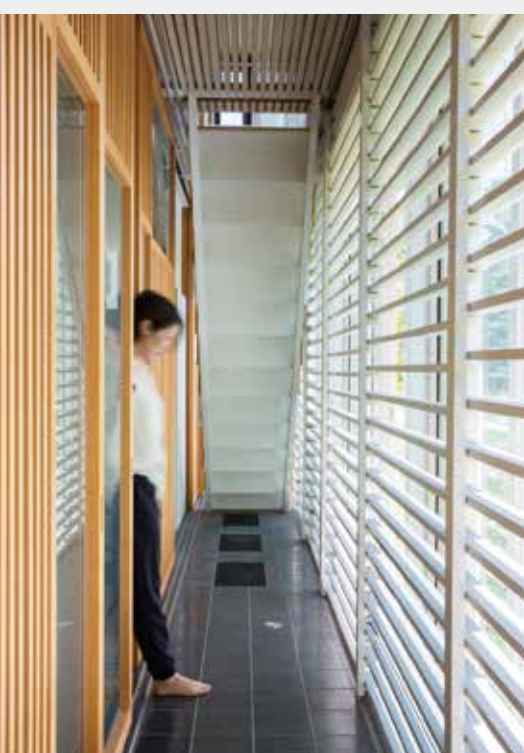
A gauche : Plusieurs panneaux alignés des deux côtés du couloir. Les panneaux d'isolation thermique et les persiennes en bois mobiles, le long des fenêtres, sont séparés de la salle de séjour par des portes vitrées. / A droite : Les panneaux d'isolation thermique sont constitués de deux couches d'une structure en nid d'abeille afin d'éviter les pertes de chaleur. (Photo : Kusu Seiko)
