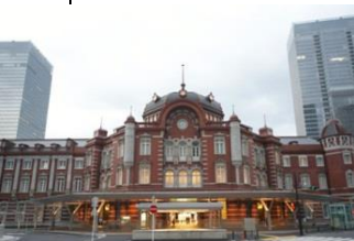
Le bâtiment Marunouchi de la gare de Tokyo dont on a reproduit l'architecture d'origine
