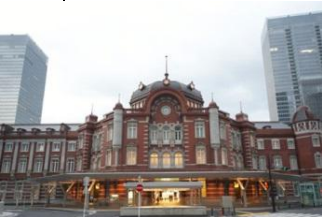
Le bâtiment Marunouchi de la gare de Tokyo dont on a reproduit l'architecture d'origine
