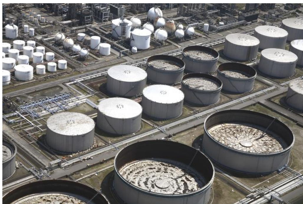
Complejo petroquímico (Foto cortesía de AFLO)
