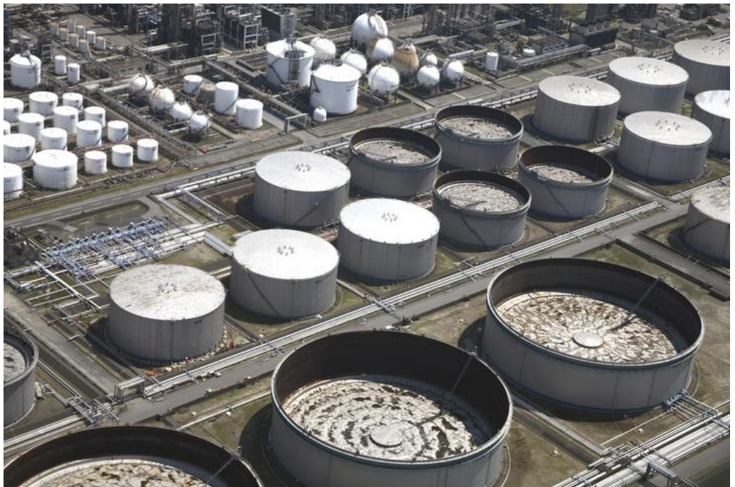
Complejo petroquímico (Foto cortesía de AFLO)
