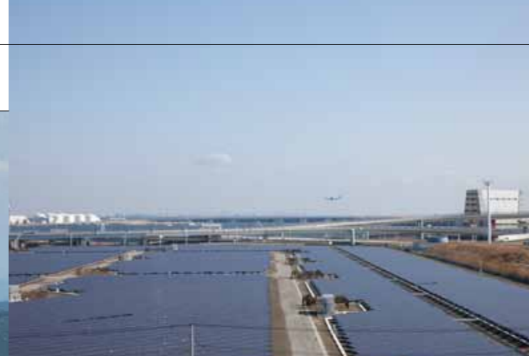
川崎市的大型太阳能光伏电站（照片：大河内 祯）
