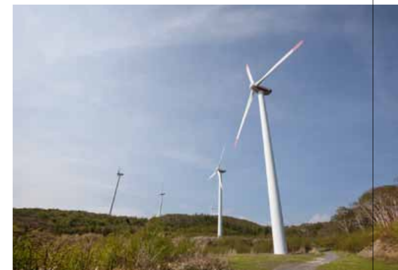
设置在环境未来城市之一的岩手县釜石市的风力发电站（照片：藤田 修平）
