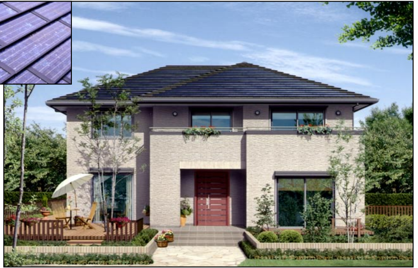
Energía solar en uso Esta casa tiene paneles generadores de energía solar en su tejado. © Sekisui House, Ltd.
